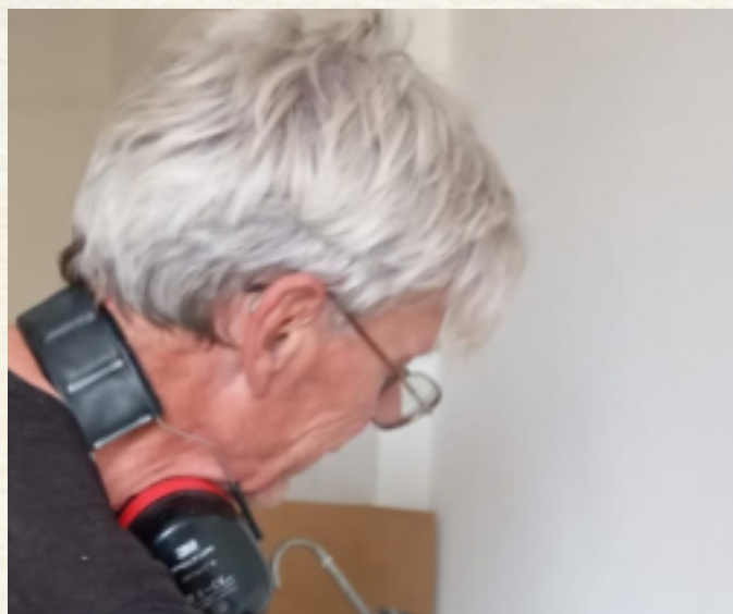
Installazione della cucina negli appartamenti
